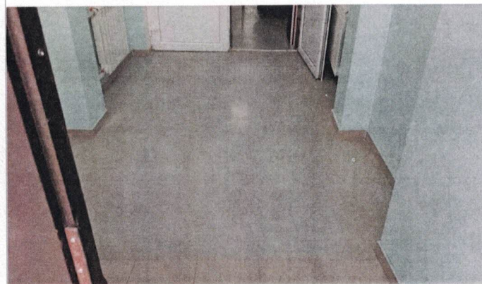
Фото № 14 – Вход в здание (главный - тамбур)
