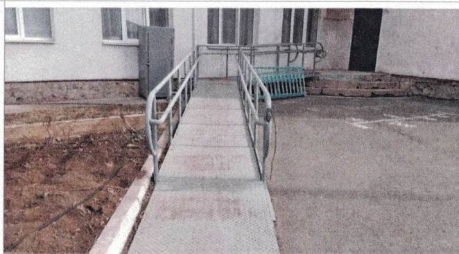
Фото №18 – Вход в здание (для инвалидов)
