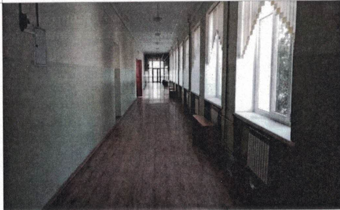
Фото №52 – Пути движения внутри здания (коридор)
