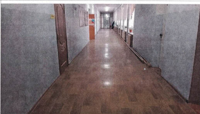
Фото №22– Пути движения внутри здания (коридор)
