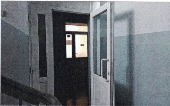
Фото №27 – Пути движения внутри здания (лестница)
