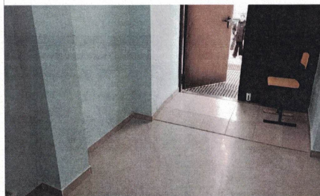
Фото № 13 – Вход в здание (главный - тамбур)
