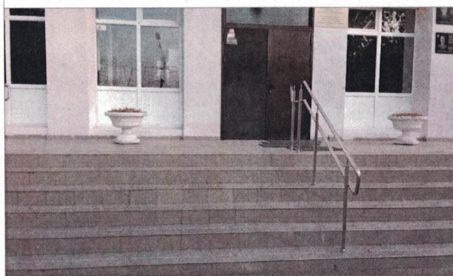
Фото № 11 – Вход в здание (главный)
