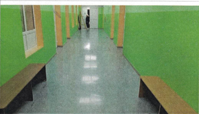
Фото №24 – Пути движения внутри здания (коридор)
