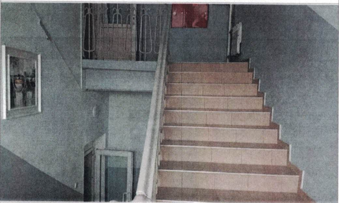
Фото №29 – Пути движения внутри здания (лестница)
