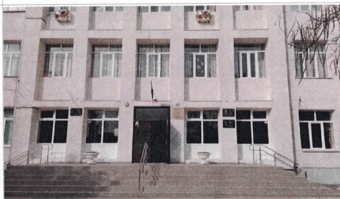
Фото № 12 – Вход в здание (главный)
