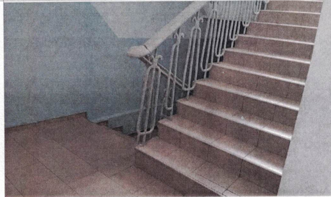
Фото №54 – Пути движения внутри здания (лестница)
