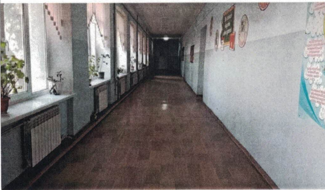
Фото №51 – Пути движения внутри здания (коридор)
