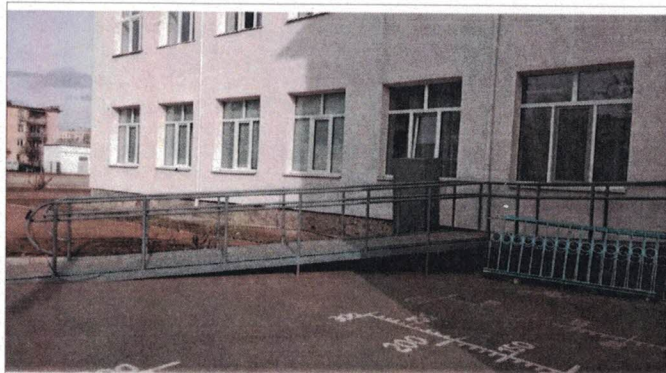
Фото № 17 – Вход в здание (для инвалидов)
